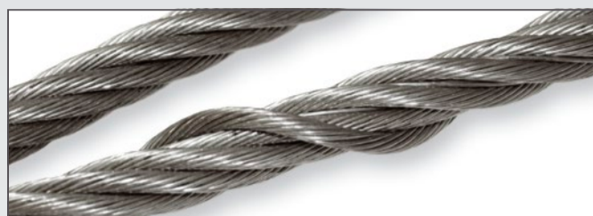
Poluzowanie warstwy zewnętrznej splotu
